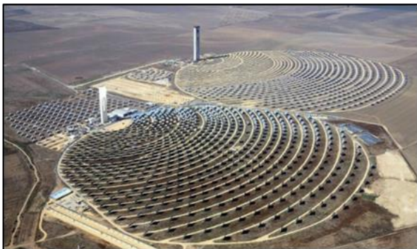
Fours solaires Ouarzazate (Haut Atlas marocain)
