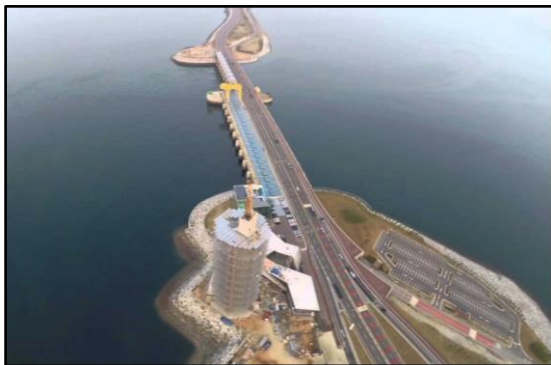
Usine marémotrice Sihwa (Corée du Sud), la plus puissante au monde 240 MW
